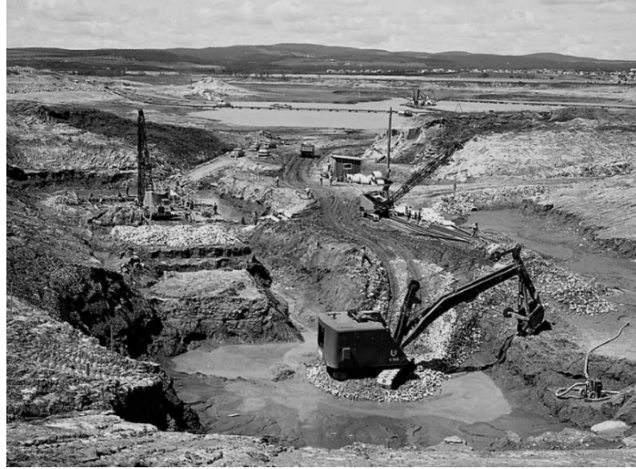
Photographie 5 Pour exploiter un important gisement d'amiante sous le lac Noir, Lake Asbestos of Quebec a détourné la rivière Bécancour qui alimentait le lac. Photo : Centre d'archives de la région Thetford. (Sources : radio-canada.ca )
